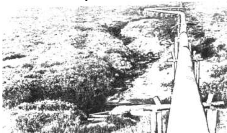
Рис. 1. Термоэрозия и оврагообразование в полосе газопровода из-за использования тяжелой техники. Протаивание вокруг металлических свай и потеря их работоспособности
