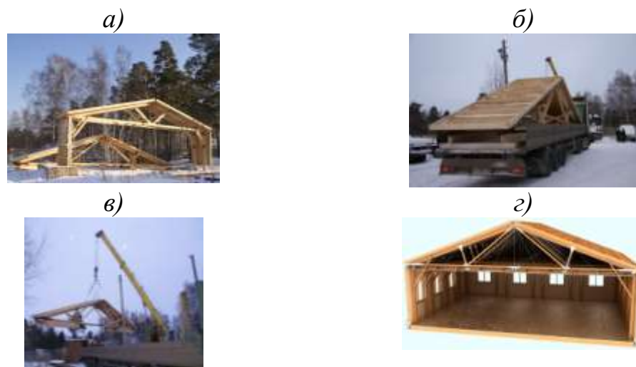
Рис. 4. Быстровозводимые здания из рамнопанельных блок-секций, устанавливаемых на фундаментные платформы: а - конструктивная схема блок-секции; б - транспортировка и в - разгрузка конструкции; г - фрагмент жилого дома
